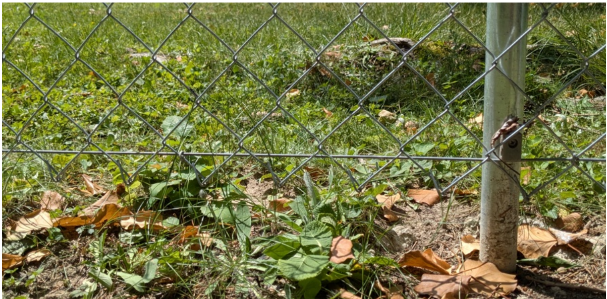
Abb. 27: Wenn Zäune bereits 10 cm über dem Boden enden, lassen sie genügend Raum für kleine Wildtiere, dass sie auf die Grünfläche gelangen können (© Sandra Gloor / stadtwildtiere.ch).
