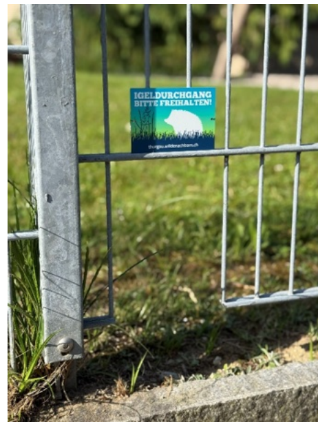
Abb. 10: Mit Hilfe eines Winkelschleifers konnten die Stahlzäune geöffnet und damit durchlässig gemacht werden (© Julia Maurer / wildenachbarn.ch und Martin Zollinger / wildenachbarn.ch).
