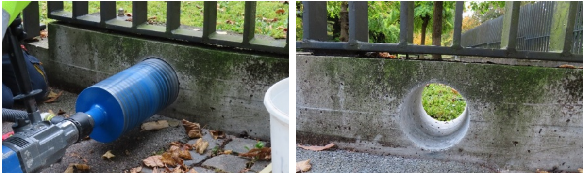
Abb. 11: Kernbohrungen in Mauern schaffen wirkungsvolle Durchgänge für kleine Wildtiere. Sie müssen von spezialisierten Firmen ausgeführt werden (© Eva Frei / wildenachbarn.ch).
