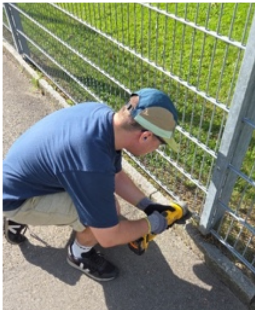
Abb. 10: Mit Hilfe eines Winkelschleifers konnten die Stahlzäune geöffnet und damit durchlässig gemacht werden (© Julia Maurer / wildenachbarn.ch und Martin Zollinger / wildenachbarn.ch).
